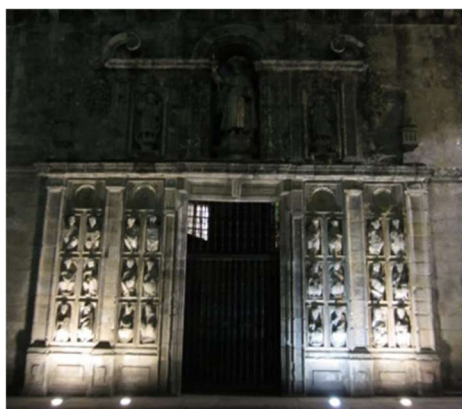
Grille d'entrée sur le corridor de la Porte
